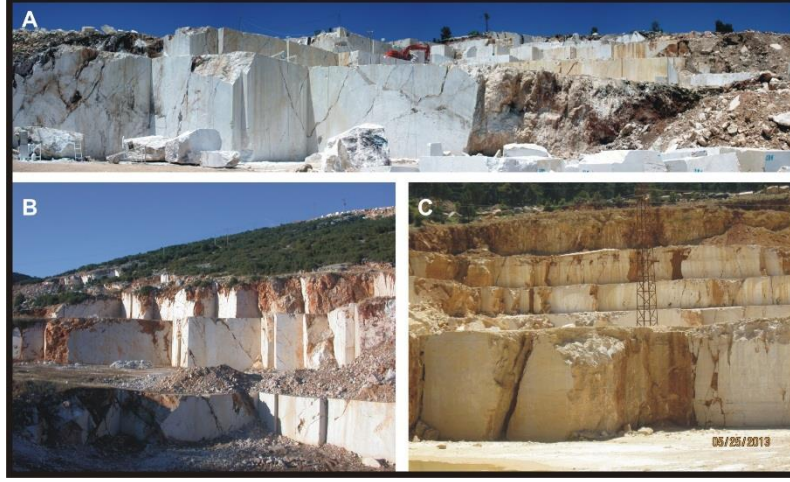
Şekil 2. Çalışma alanı içerisinde görülen ocaklardaki süreksizlik düzlemleri
